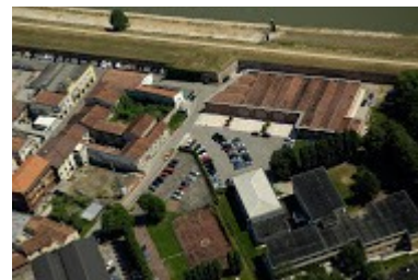
Vista aerea delle strutture che compongono il centro
