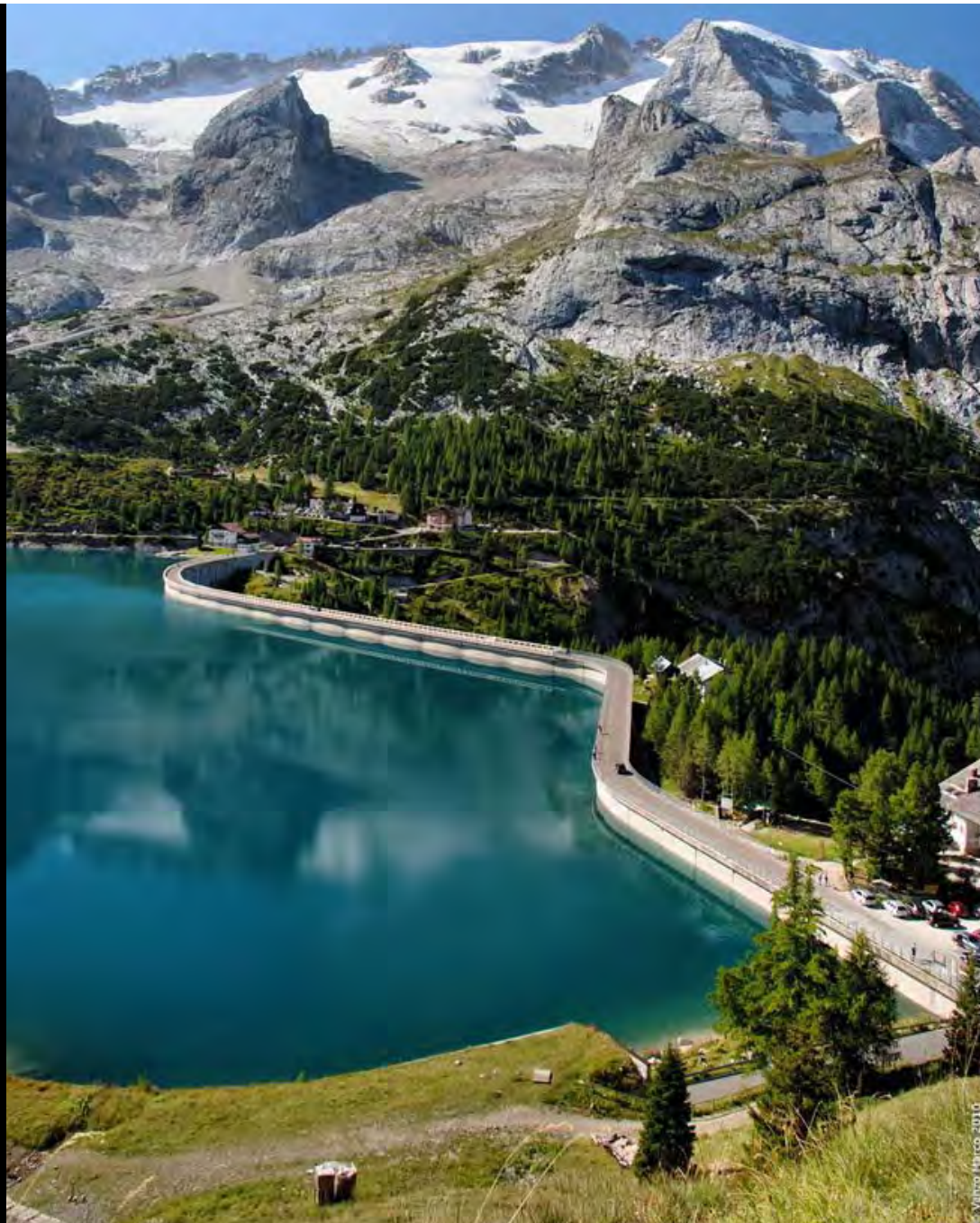
Lago artificiale e diga di Fedaia sotto la Marmolada
