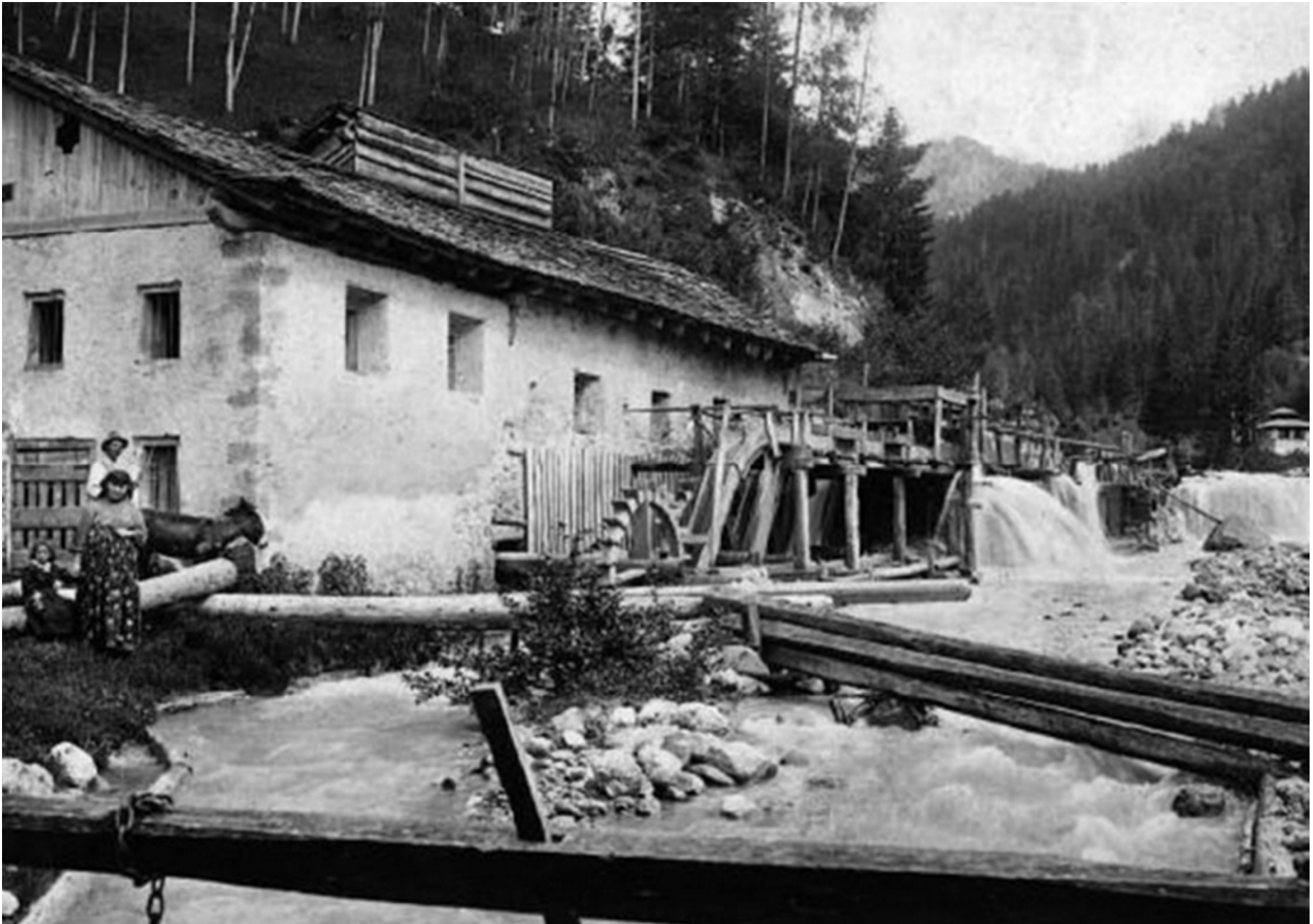
Trasformazione dell'energia potenziale in cinetica (Mulino sul Piova a Vigo di Cadore)
