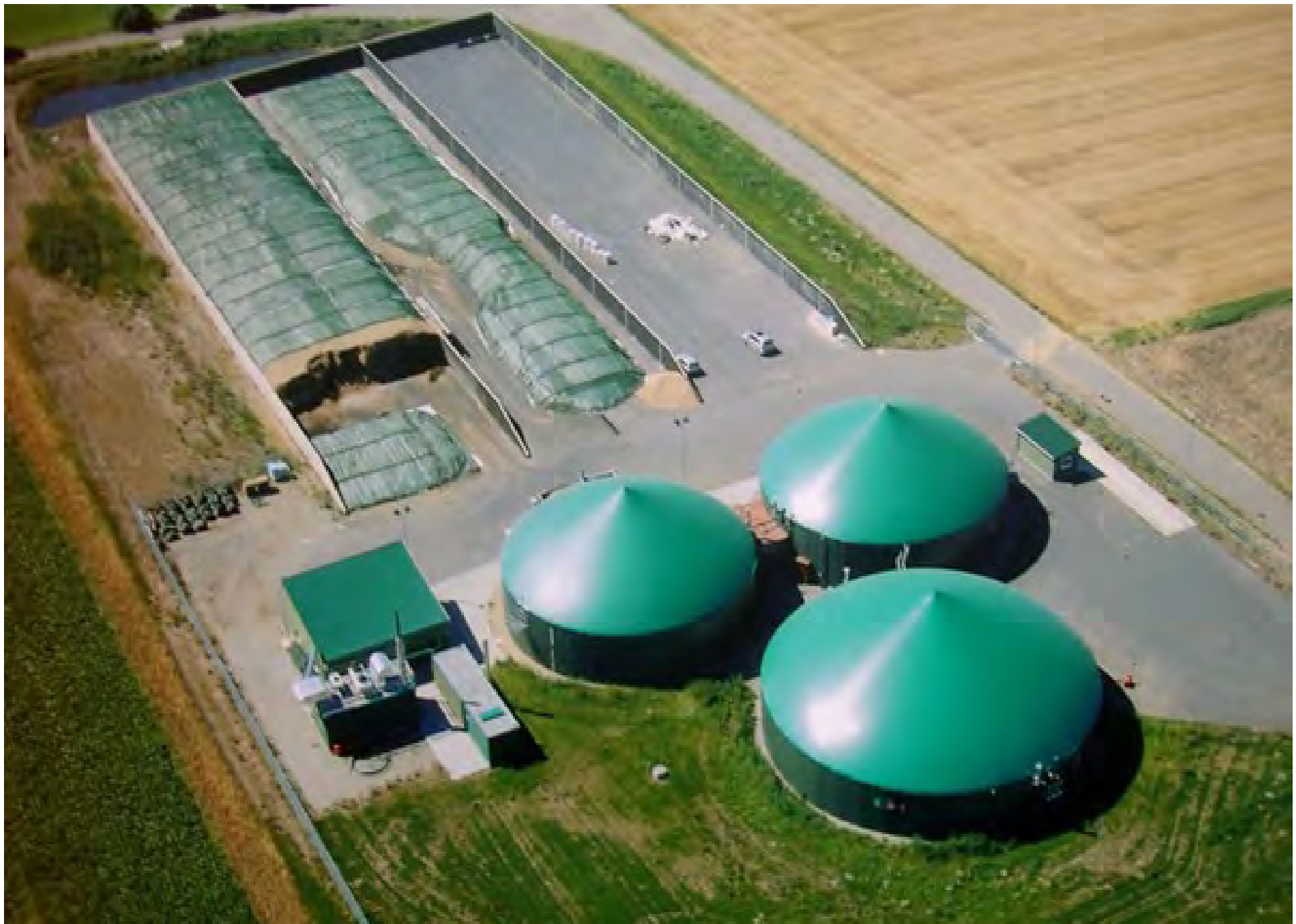
Paesaggi dell'energia... un impianto a biogas
