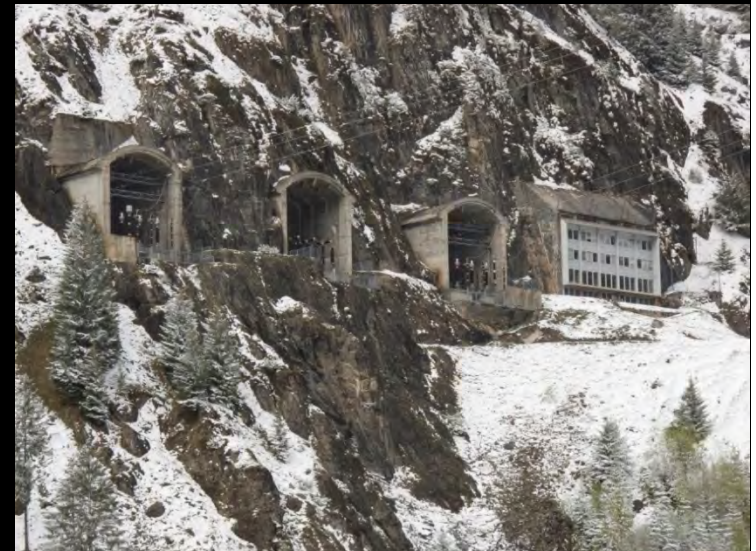
Power plant of Fionnay - Val de Bagnes
