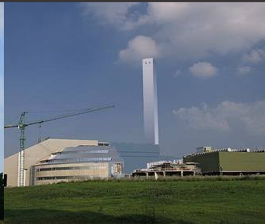
Termovalorizzatore, Brescia, J.Tornquist
