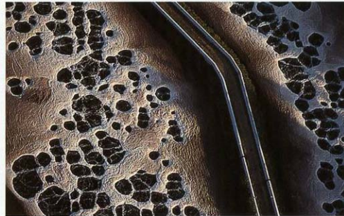
Natchez, Misisipi. Borbotadores de aireación de una planta de tratamiento de residuos en una fábrica de papel.
