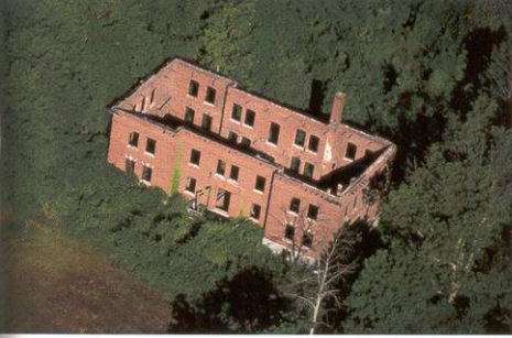
Boston, Massachusetts. Edificio abandonado de estructura de ladrillo.
