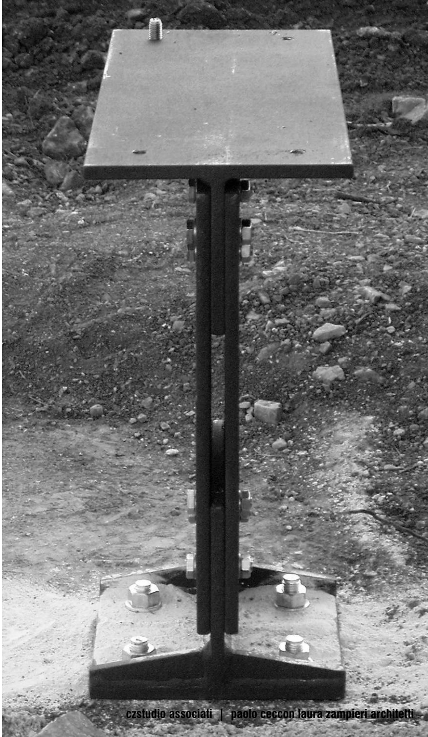
Piastra superiore (spessore 10 mm.) fissata con bulloni M12 alle piastre di pietra
